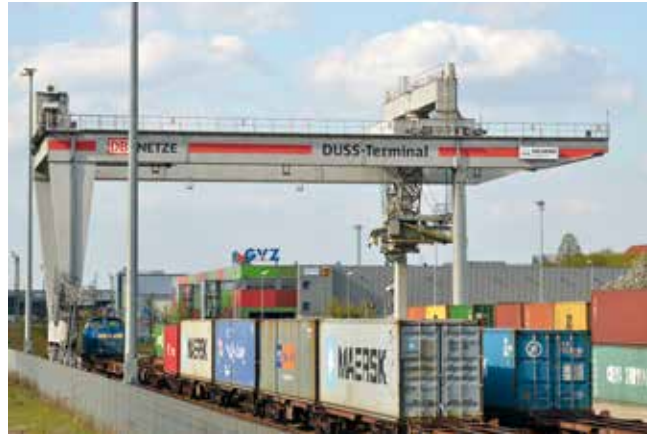
DUSS-Terminal Göttingen mit Umschlaganlage KV
